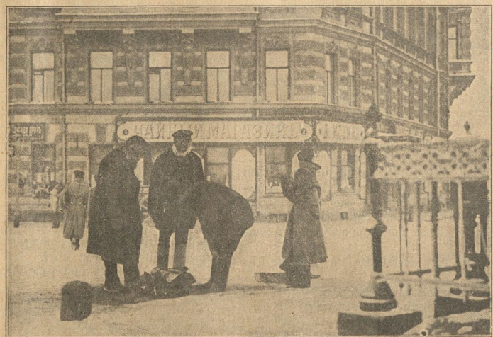
Brennende Holzfüsse in den Strassen Petersburgs zur Erwärmung der Strassenarbeiter.
