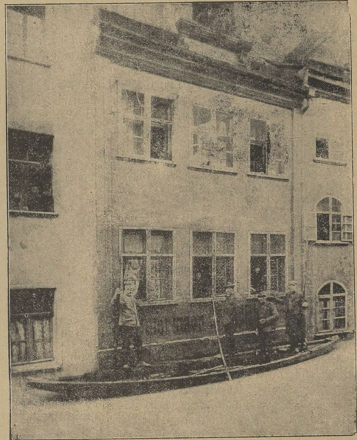
Verkehr auf den durch das Hochwasser gefährdeten Straßen der Stadt Nürnberg.
