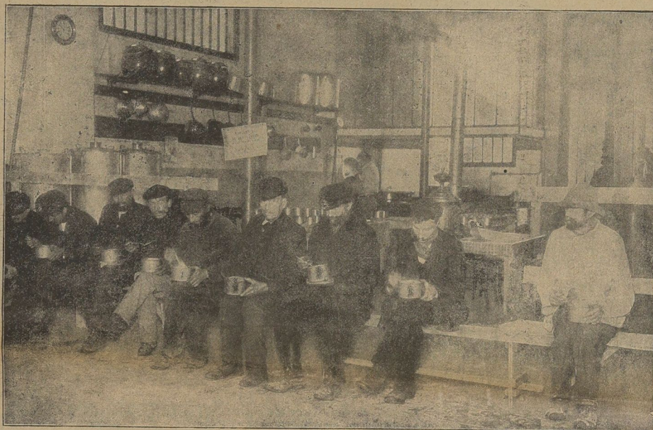
Das Innere des Pavillons zur Suppenausgabe an Obdachlose in der Rue Notre-Dame in Paris.
