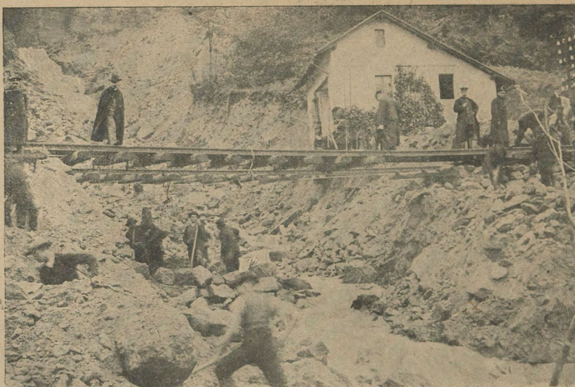
Das unterirdische Bahngelände bei Pirna.
