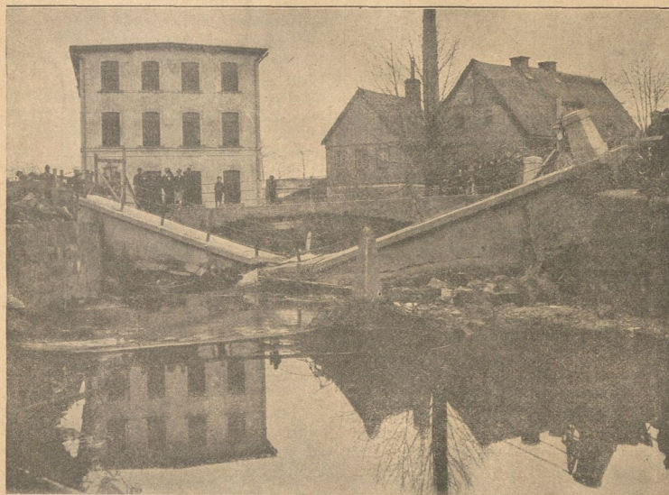
Einsturz der neuen eben dem Verkehr übergebenen Brücke über die Mandau bei Oberhennersdorf in Böhmen. Photographische Aufnahme von Hermann Lüh, Seiffhennersdorf i. Sa.
