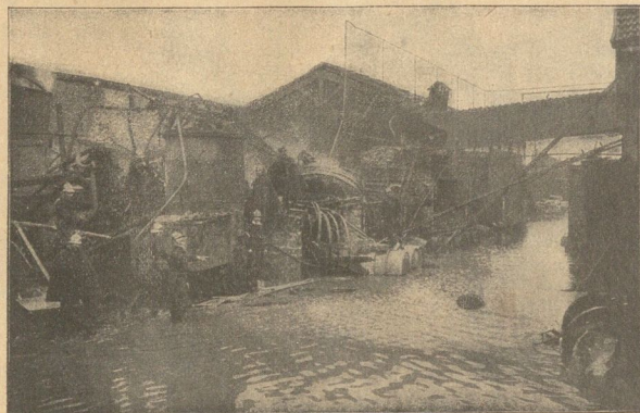
Die Sintflut in Paris: Das Seinehochwasser verursachte in Jhre den Brand einer Fabrik chemischer Produkte. In den überschwemmten Fabrikräumen befanden sich größere Massen von Säurestoffen, die durch ihre Verbindung mit dem Wasser Gase erzeugten und so zu einer Explosion führten.
