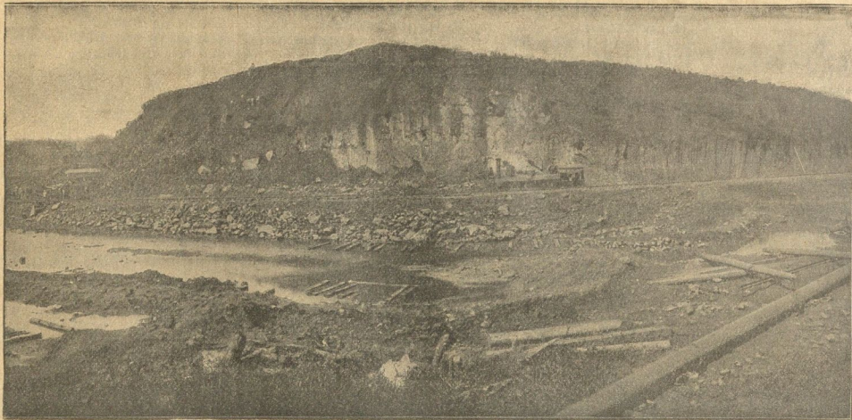
3. Ausbaggerungsarbeiten bei Gatun, der Mündung des Panamakanals in den Stillen Ozean. Durchhauung mächtiger Felsenwände, Auffangung eindringender Wasser des Chagresflusses in das Kanalbett durch große Saugpumpwerke.
