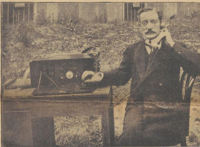
Die drahtlose Telephonie: Der Sendeapparat.
