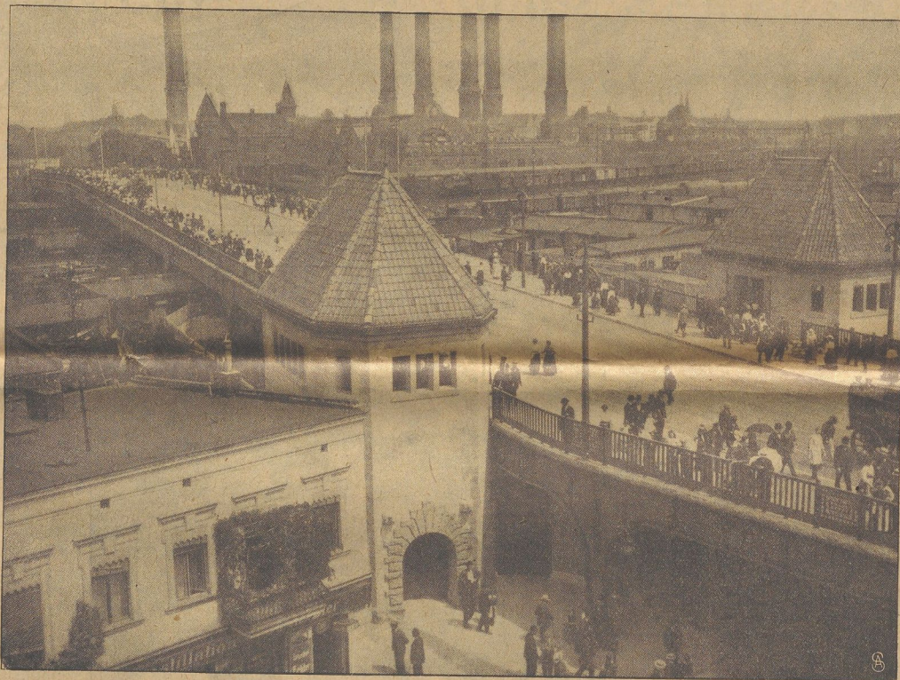
Die neue Riesenbrücke der Putliß- und Föh- rer Straße in Groß-Berlin nach der Eröffnung.
