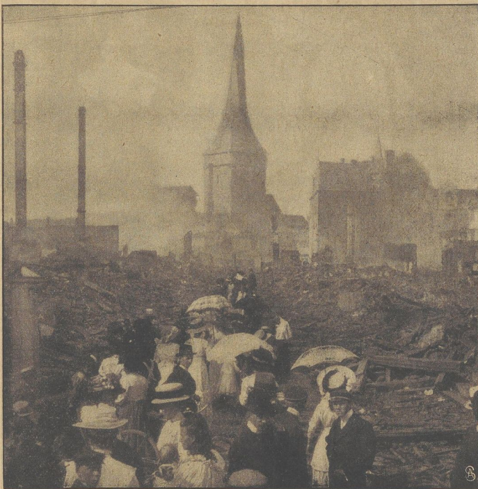
Ein Blick auf das Trümmerfeld in Duderstadt nach dem großen Brande. Auch die Hauptstadt des Eichsfelds ist durch eine der jetzt so häufigen Brandkatastrophen betroffen worden. 30 Häuser, darunter eine Schule, wurden zerstört.
