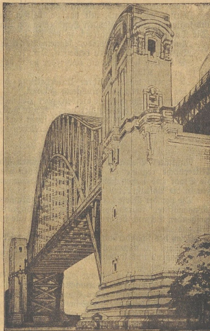
Die größte Brücke der Welt mit ihrem 70 Meter hohen Turme.
