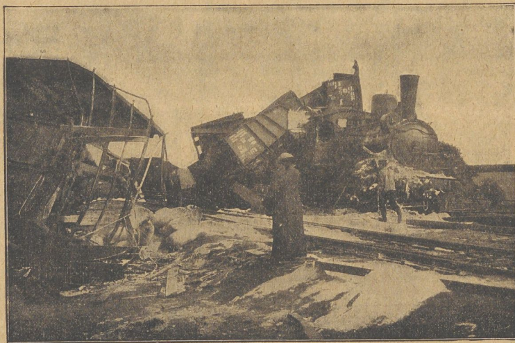
Der Schauplatz des Eisenbahnunglücks bei Hargow. Auf der Strecke Neustrelitz—Waren stießen zwei Güterzüge zusammen, wobei die Maschinen sowie 15 Wagen in Trümmer gingen. Mehrere Personen wurden erheblich verletzt.
