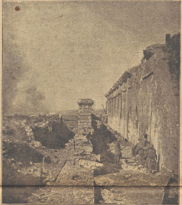
Die zerstörte Zitadelle und der Graben des Forts Baug.
