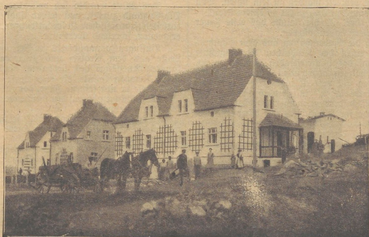
Die Kriegerheimstätten-Kolonie in Reichenbach (Oberlausitz); Wohnstätten der Kolonie, welche aus Einfamilienhäusern besteht.
