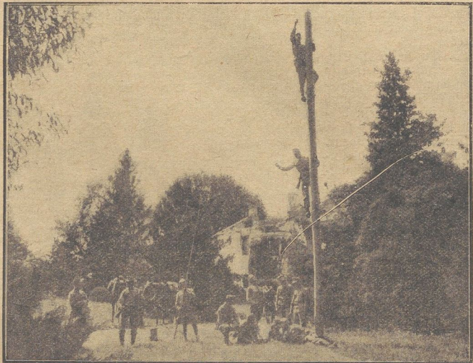
Oesterreichische Honvedhufaren beim Legen von Telephonleitungen auf dem Balkan-Kriegsschauplatz.
