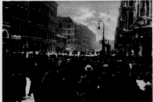
Zur Explosionskatastrophe in Berlin. Das Unglückshaus in Moabit, dessen Zugänge von der Polizei gesperrt worden sind. Die Katastrophe, verursacht durch Benzin- oder Gasexplosion, hatte bekanntlich den Einsturz eines Teiles des vierstöckigen Hauses herbeigeführt, wobei nicht weniger als 12 Tote und über 30 Verletzte in den Trümmern begraben wurden.
