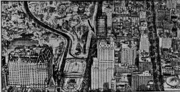
In New York brach, wie gemeldet, in dem Neubau des New Netherlandhauses, der 88 Stock hoch ist, und in der belebtesten Gegend New Yorks an der Ecke der 5. Avenue liegt, ein gefährlicher Brand aus, bei dem glücklicherweise keine Menschenleben vernichtet wurden, da das Hotel noch nicht bewohnt ist. — Unser Bild zeigt die 5. Avenue mit dem Hotelneubau.
