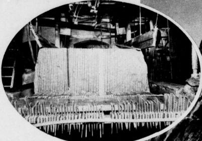
Eine große Säge zererschneidet die Steinblöcke in leichter zu bearbeitende Platten.
