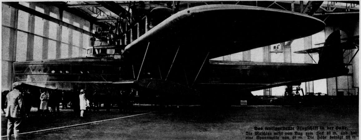
Das sechsstellige Flugschiff in der Halle. Die Maschine mißt vom Bug zum Heck 40 m, und hat eine Spannweite von 48 m. Die Höhe beträgt 10 m.
