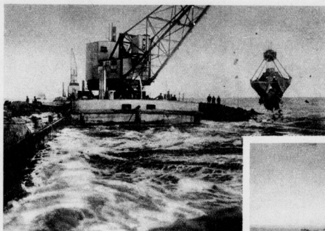
Einer der zahllosen Kräne, die immer aufs neue Erdmassen in die See schleudern, beim Wert.
