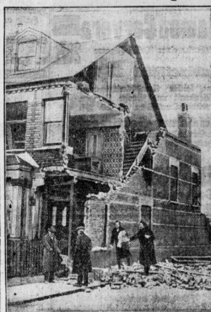
Unter Bild zeigt ein von dem heftigen Sturm, der in den letzten Tagen über Süd-England tobte, schwer beschädigtes Haus in Dufford Walthamton.
