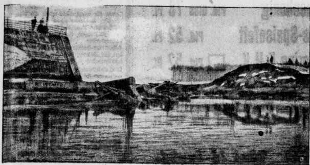
Der geborstene Staudamm.
