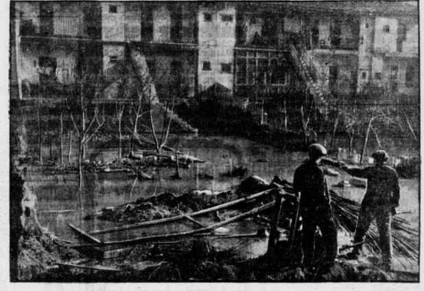
Verfüßte Häuser in Saragossa, das von den Fluten des über die Ufer getretenen Ebro schwer heimgesucht wurde.
