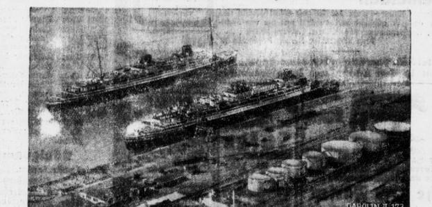
Die beiden deutschen „Europa“ und „Bremen“ vor der Dapollin-Großbunkerstation, die für die Schiffe neu gebaut worden ist. Länge der Kaje, die über einen Kilometer lang ist, erstreckt sich ein unterirdisches Bohrungsnetz, so daß die „Säuberung“ der beiden Dampferinnen an ihren regulären Bunkerplätzen auf einfachste und schnellste Art innerhalb weniger Stunden erfolgen kann. Für eine Heberperiode werden ca. 5000 bis 6000 m. Standard-Geöl, das fast zehn lange Güterzüge, je Schiff benötigt.
