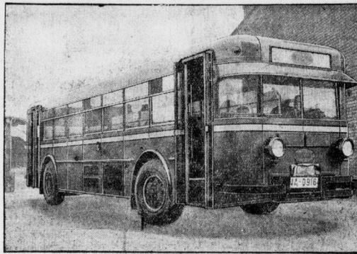
Der neue Automobils der Berliner Verkehrsgesellschaft, wegen seiner zwei Motoren „Zwiebus“ genannt, wurde soeben in Betrieb gestellt. Die beiden Motoren sind rechts und links vom Führeris gelagert und geben so
