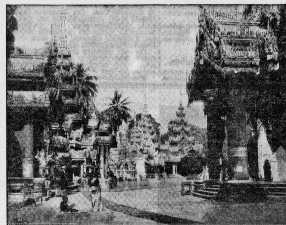
die durch das Erdbeben schwer beschädigt wurde.
