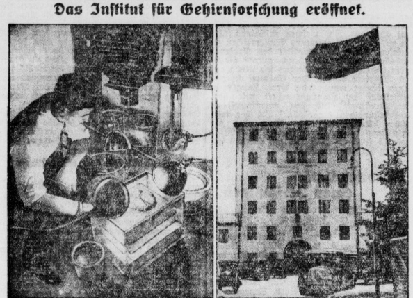
Das Institut für Gehirnforschung eröffnet. Das neue Gebäude des Instituts für Gehirnforschung der Kaiser-Wilhelm-Gesellschaft. Gehirnforschung der Kaiser-Wilhelm-Gesellschaft. Der Leiter des Instituts ist der weltbekannte Gehirnforscher Prof. Dr. Vogt.
