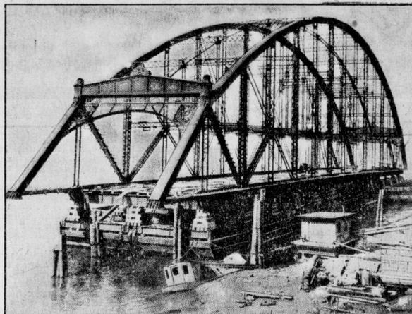
Kein Pan einer Brücke über den Obis (H. S. A.) wurde der vollkommen fertige Brückenbogen auf Pontons der Fluss hinuntergefahren, um an Ort und Stelle fest zu werden. Diese Art der Brückenmontierung bringt eine große Zierlichkeit mit sich.
