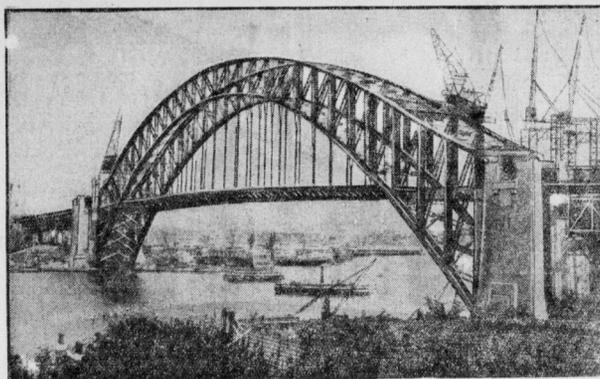
Im Hafen von Sidney (Australien) verbindet nunmehr die größte und teuerste Brücke der Welt den nördlichen und südlichen Stadtteil. Die Gesamtlänge der Brückenbrücke beträgt 1200 Meter, die höchste Stelle des Bauwerks liegt 113 Meter über dem Meeresspiegel. Außer einer breiten Fußgänger- und zwei Wegen für den Fußgängerverkehr trägt die Brücke vier Eisenbahngleise.
