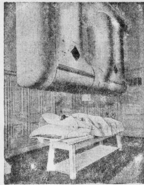
Ein neuerer Röntgen-Apparat, der die Bestrahlungsleistung in bisher nicht dagewesener Weise vervollkommnet. Der Apparat ist mit Ketten an der Decke befestigt und gegen Hochspannung durch Metall vollständig abgedichtet und strahlungslosicher. Seine große Bewegungsmöglichkeit ist für die genaue Einstellung von besonderem Wert.
