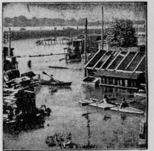
Vom Hochwasser überflutete Bauhäuser am Oderdamm bei Neufals.
