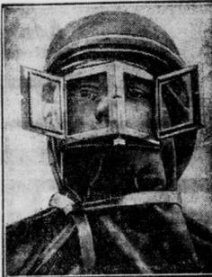
Dieser neuerdings in England eingeführte Apparat für Feuerwehretzte ist eine Verbindung von Gasmaske und Sturzhelm zum Schutz gegen Rauch und Gase und herabfallende Brandtrümmer. Die Augenklappen lassen sich wie Fensterläden öffnen.
