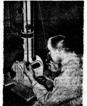
Ein Uebermikroskop für das Robert-Koch-Institut Dem Robert-Koch-Institut wurde ein Elektronen-Uebermikroskop übergeben, das in vielmotoriger Gemeinschaftsarbeit mit dem AEG-Forschungsinstitut erprobt worden war. Unser Bild zeigt das neue Gerät, das für die Volksgesundheit äußerst wichtig ist. Die maximale Vergrößerung des Mikroskops ist 500 000fach
