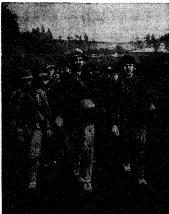
Wahl: Dr. Vincenz, Werk-Volk-Zentrale, Jander-R. Westwallarbeiter. — Nach der Schicht marschiert die Kolonne in ihr Lager zurück. Tag und Nacht wird an dem größten Verteidigungswerk aller Zeiten gearbeitet
