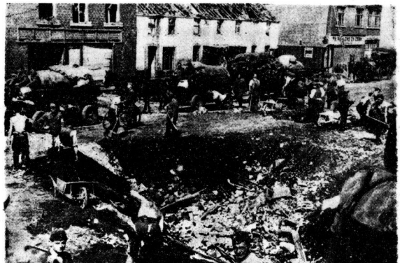
Straßensprengungen sollten deutschen Vormarsch aufhalten. Die Sprenglöcher sind meter tief, Soldaten und Bauabteilungen, die den vorgehenden Truppen auf dem Fuße folgen, sind dabei die Sprengtrichter auszufüllen.
