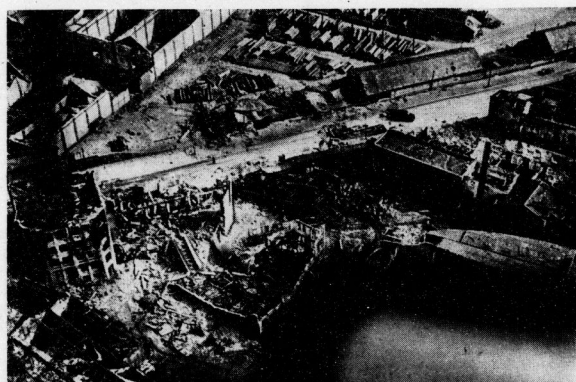
Die Hafenanlagen von Le Havre nach einem Stukangriff
