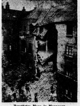
Zerstörtes Haus in Hannover
