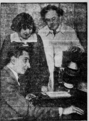
Der Erfinder Thomas (stehend) vor seinem „Photo-Elektrographen“, einem Apparat, der es ermöglicht, jede gewöhnliche Druckschrift zu entziffern. Durch besondere Vergrößerung erscheint das gewöhnliche Druckbild in erhabener Form auf dem Empfangsapparat, wo es von den Blinden mit den Fingern gefühlt werden kann. Der Erfinder, der infolge einer Kriegsverletzung selbst blind war, hat seinen Apparat den Anfallen einer Blindenanstalt bereits vorführen können.
