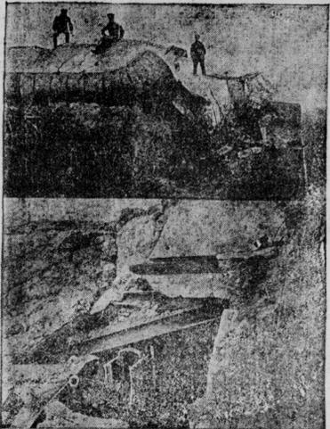
(Obere Bild): Die Wirkung der 42 cm Mörser von Krupp und Skoda an einem Panzerfort auf Forts 11: Die Skulptur eines Geschützturnes, welche 30 m weit durch die gewaltige Explosionskraft der Geschosse fortgeschleudert wurde. (Untere Bild): Ein russisches Festungsgeschütz im Forts 11, dessen meterstarke Eisenbetonierung durch einen 42 cm Treffer abgeprengt wurde. Vom Generallstab zur Veröffentlichung genehmigt.
