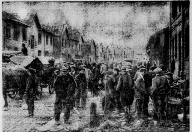
In den Straßen der zerstörten Stadt Neunkirchen, Eine Straße der Unglücksstadt Neunkirchen: durch den gewaltigen Luftdruck sind hier sämtliche Häuser abgedeckt worden.
