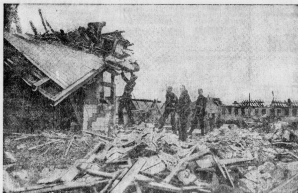
Bergungsarbeiten in Neunkirchen.
