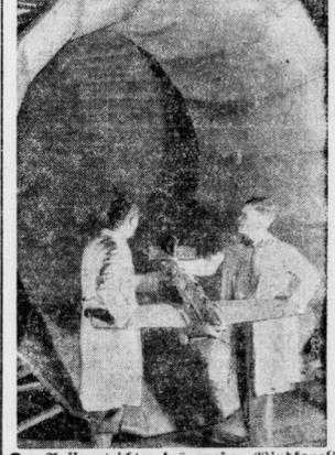
Der Ausfallstrichter des großen Windkanals mit einem Ringwindmodell.
