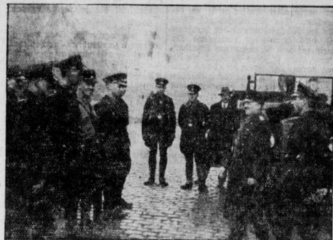
SS. vor Abrtransport zu einem Sonderauftrag
