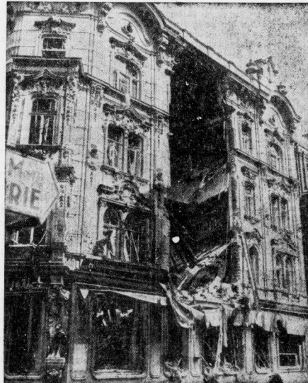
Das durch Explosion zerstörte Hotel „Europa“ in Brünn.
