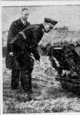
Darcs erster Spatenstich am Eberdamm.
