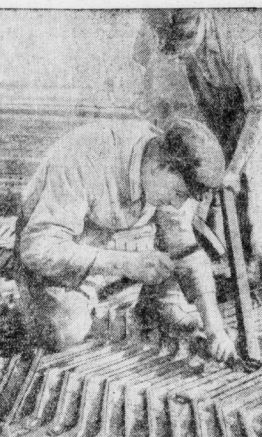
Eine Strafe wird aus Stahl gebaut.
