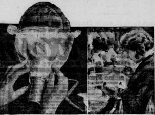
Eine fertige Maste wird auf undichte Stellen Die Rabitiche ber Rasten werden mit überprüft, die fich durch rote Fleden auf dem Gummi gedichtet.
