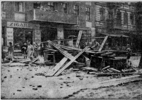
Die aus Zementplatten, Pflastersteinen und aus Müllkästen errichteten Barrikaden in der Hofhofer Straße in Berlin-Moabit.
