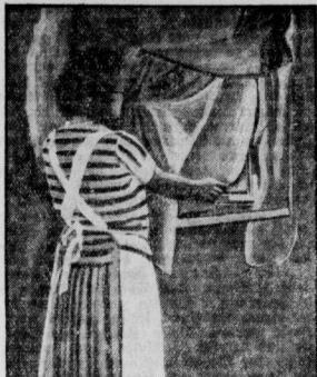
Abdichten der Kellerfenster.
