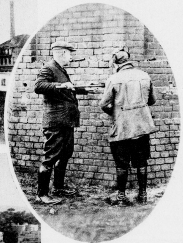
Anlegen der Sprengföbber in den Unterbau des Schornsteins.
