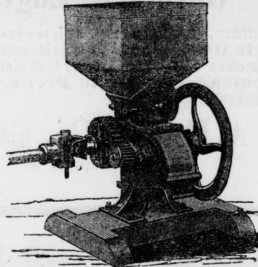
Schrotmühle für Göpelbetrieb, zum Schrotten von Mais, Gerste, Erbsen, Bohnen u. c. Die Theile, welche das Zerhacken resp. Zerreißen der Körner u. c. besorgen, sind aus gehärtetem Gußstahl gefertigt, die, wenn sie nach längerem Gebrauche stumpf werden, leicht zu schärfen sind. Die Schrotmühle kann an jedem vorhandenen Göpel gekuppelt werden, erfordert sehr wenig Betriebskraft, wenig Platz zur Aufstellung, ist leicht handthierbar und leicht zu transportiren. Zuverlässige Agenten werden gesucht.
