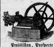
empfehle seine gasdrücklosen horizontalen Gasmotoren, welche ohne Concession u. ohne Baueinfundament in allen Etagen bewohnter Häuser aufgestellt werden können und feiner Benutzbarkeit bedürfen, als bequame, billige, gasfabrixe und zu jeder Zeit bereitete Betriebsmaschine für industrielle u. gewerbliche Zwecke, für Pumpen u. Aufzüge.
