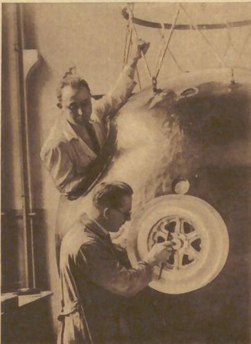
**Zum Aufstieg in 16 Kilometer Höhe.** Zur Nachprüfung seiner theoretischen Berechnungen will der belgische Professor Piccard selbst in einem wasserstoffgefüllten Ballon in die Stratosphäre aufsteigen. Der „Ballonkorb“ ist eine geschlossene Kugel aus Aluminium. — Piccard mit seinem Assistenten bei den Vorbereitungen
